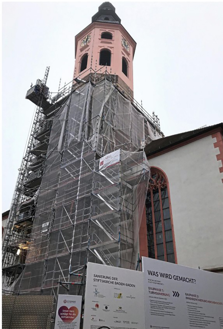
Arbeiten auf dem Gerüst: Um Steine am Turm der Stiftskirche Baden-Baden hat sich Restaurator Luzius Kürten zusammen mit Steinmetzen gekümmert. Foto: Michael Rudolphi
